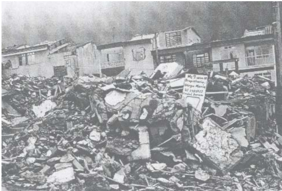
Daños producidos en construcciones. Intensidad V-X Armenia. Enero de 1999
