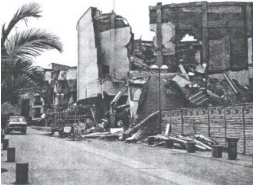
Daños producidos en construcciones. Intensidad V-X Armenia. Enero de 1999
